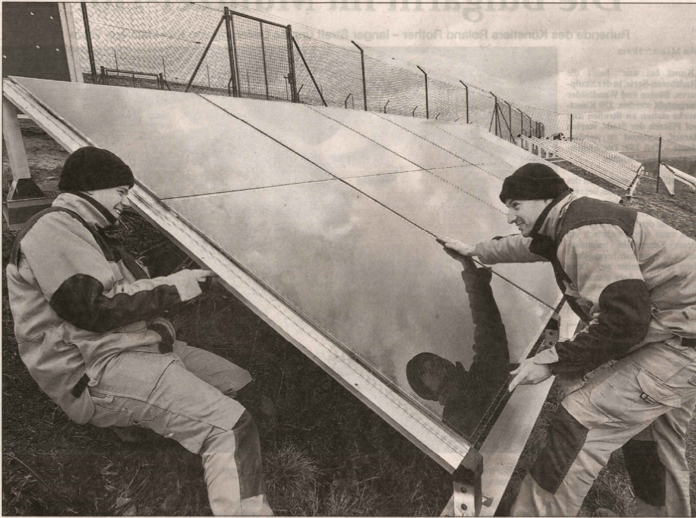
Moderne Technik: Matthias Fritzl und Stephan Seibert (r.) von den Deutschen Solarwerken installieren auf dem Drachenberg am Fernsehturm eines der ersten Solarmodule in eine Pirmin-Halterung. Die Halbertechnik wurde von den Solarwerken entwickelt. Insgesamt wollen beide mehr als 100 Solarmodule einbauen. Bis Jahresende sollen rund 500 Solarzellen installiert sein. Mit solchen Modulen kann man Sonnenenergie in Strom umwandeln. Fotos (2): GMD/Dietmar Horn
