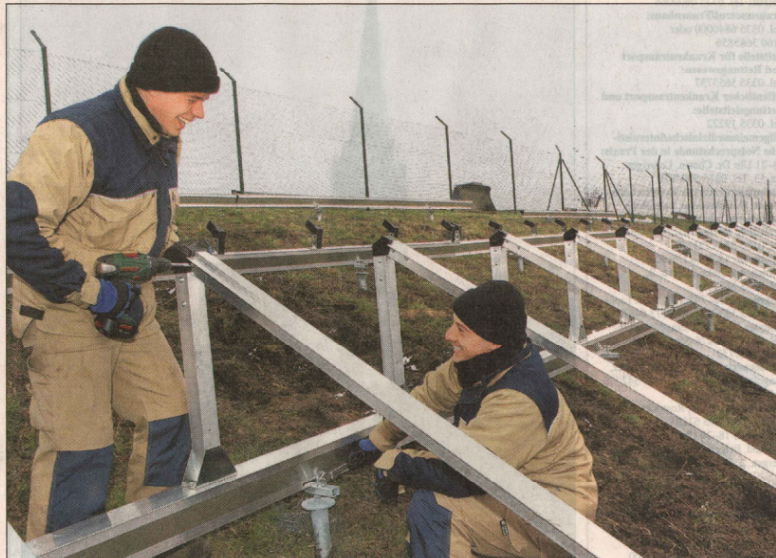
Ständer für Solarmodule: Matthias Fritzl und Stephan Seibert von den Deutschen Solar Werken installieren auf dem Drachenberg ein Aufständerungssystem, auf dem die Solarmodule befestigt werden. Fotos (2): GMD/Dietmar Horn
