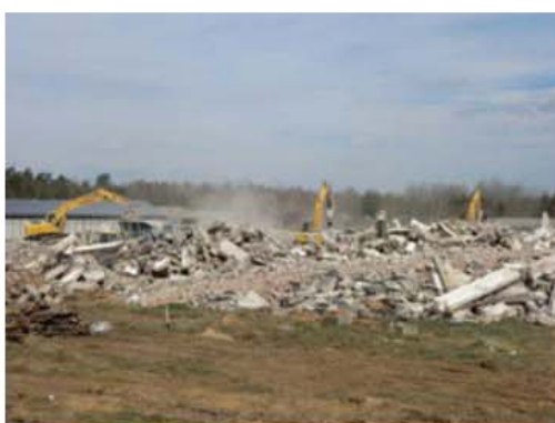
Für das Solar-Kraftwerk mussten Kasernengebäude und Bunker abgerissen werden
